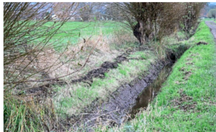
Erst wenn die anliegenden Grundstücke in öffentlicher Hand sind, kann der zentrale Entwässerungsgraben in der Rauhen Horst zurückgebaut werden.
